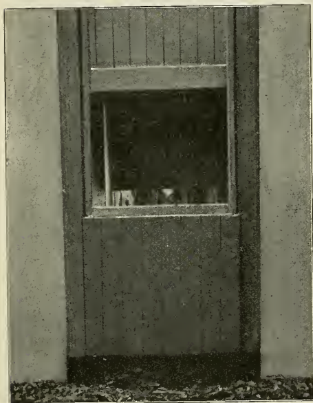
Fig. 11.—Straight Door Set in Door Frame.
