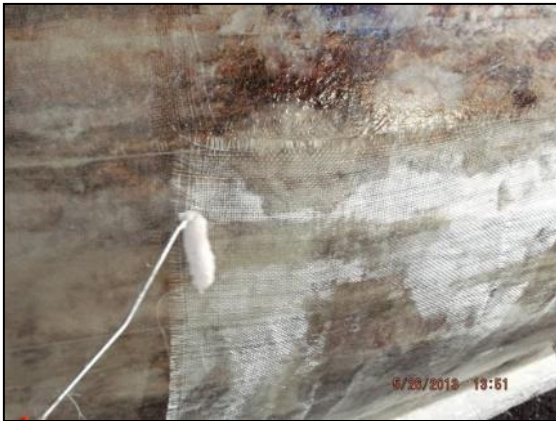
Gambar 14 Pelapisan dengan roving
