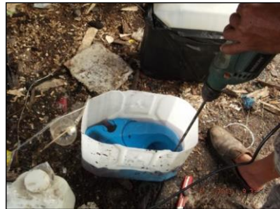
Gambar 21 Pencampuran bahan cat
