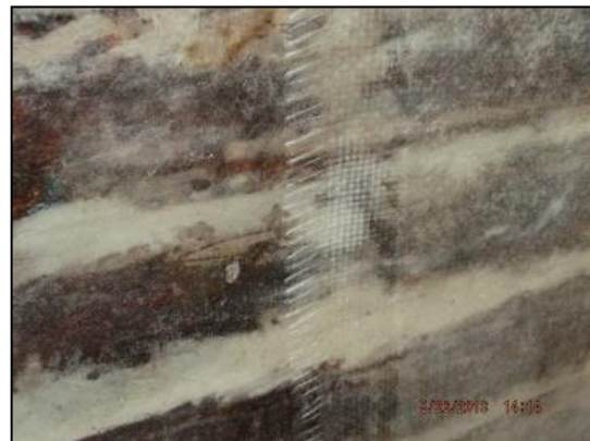
Gambar 17 pelapisan dengan mat
