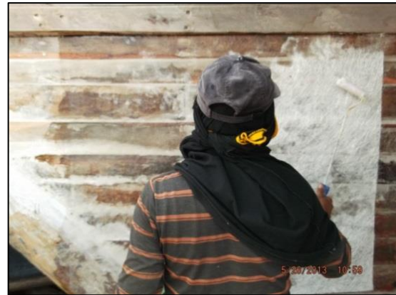
Gambar 13 Pelapisan dengan mat
