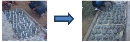
Gambar 2. Urutan kerja pembuatan rak meja transplantasi karang
