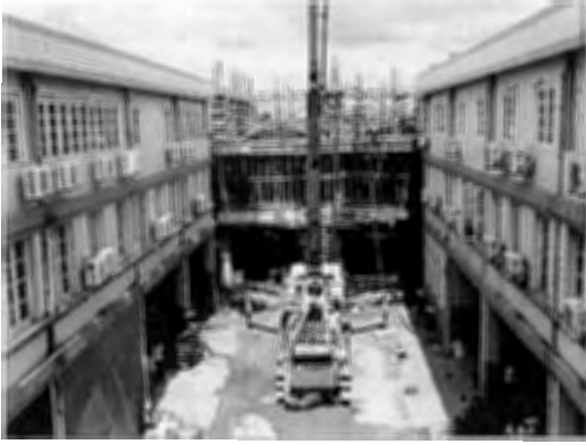
写真9 建設中の新棟. 1フロアが精神科専用となる予定
