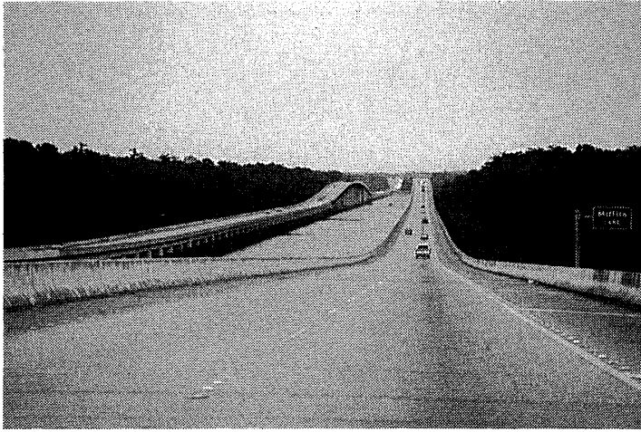
レークチャールズ付近の沼沢地 ミシシッピ川デルタは、サビーン川やバンディック川など無数の分流河川が南流しており、東西を結ぶ1の10号線は橋梁又橋梁。ポーモントを出るとレークチャールズ、ラファエット、ミシシッピ本流のバトンルージュまでこうした景観がずっと続く。（ルイジアナ州）
