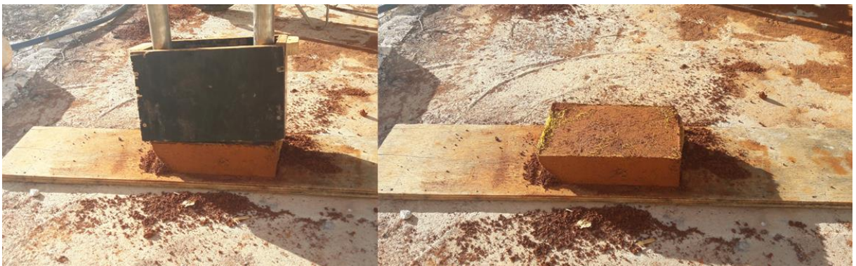
Figura 4 – Retirada da forma.
