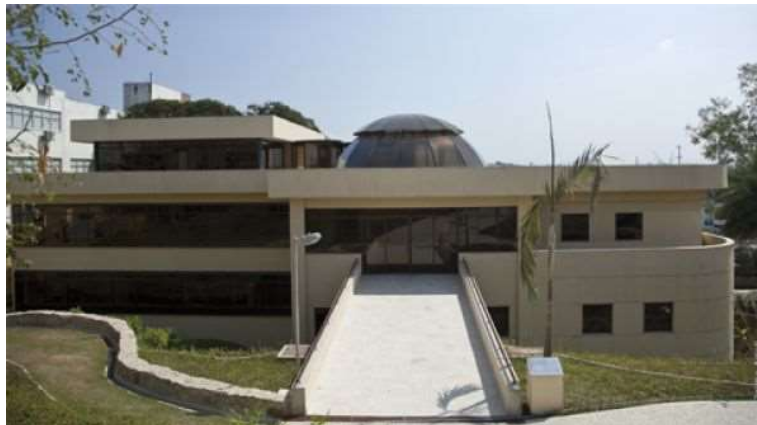
Figura 2: Prédio anexo do Mast 4
