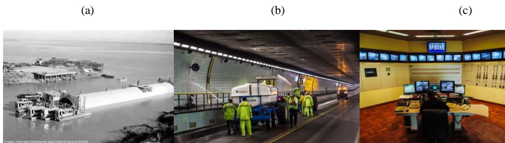
Figura 1. Fotos del complejo túnel sub fluvial Urunga - Silvestre Begnis. (a) construcción, (b) interior y (c) sala de control. Fuentes: (a) www.tunelsubfluvial.gov.ar , (b) www.welcomeargentina.com ; (c) www.santafeturismo.gov.ar
