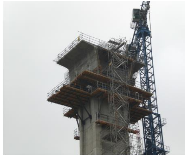
Figura 5. Vista de la ejecución de la dovela 0 en el viaducto de Tenoya, en Tenerife (España). Fuente. https://elblogingenierocivil.wordpress.com/
