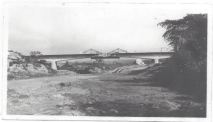
Figura 1. Ejecución del puente Currulao en Uraba (1962). Fuente. Ingeniero. Mario Rodríguez – Precomprimidos S.A.
