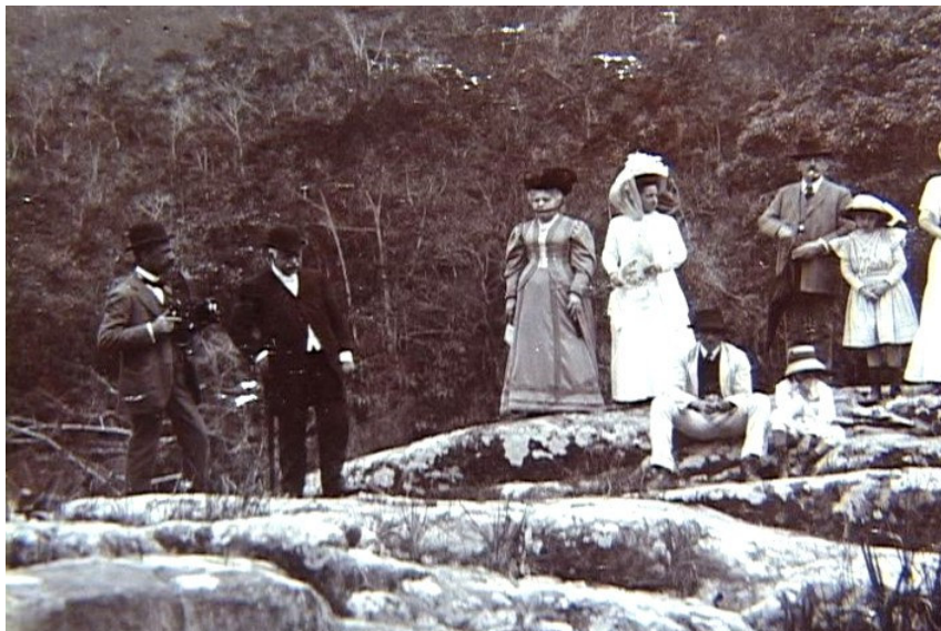
FIGURA 3. Visita às obras da primeira usina de força
