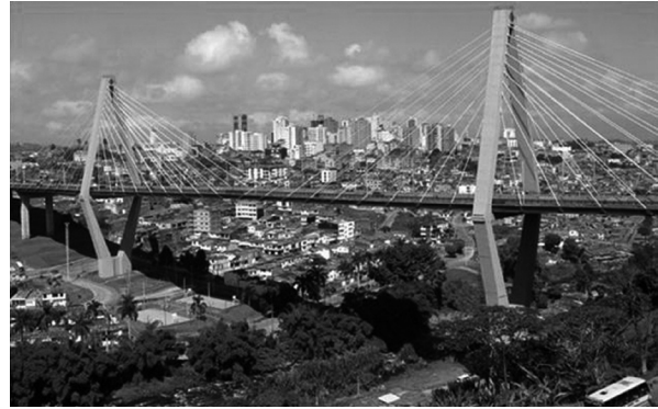
Figura 7. Viaducto Pereira Dos quebradas.
