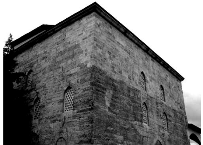
Şekil 2. Gümüşlü Camii'nde 18. yy tamir izleri
