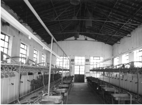
Şekil 6. Turgut Yılmazipek ipek fabrikasına ait mancınıkhane ünitesi, 2000
