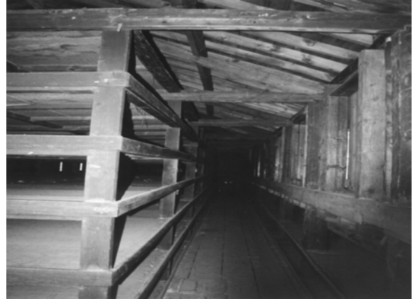
Şekil 5. Turgut Yılmazipek ipek fabrikasına ait kozaklık ünitesinin çatı katı, 2000
