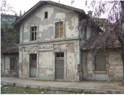
Şekil 5. Dil İskelesi yolcu binası, 2006
