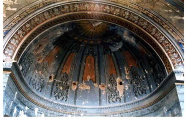
Şekil 21. Tavlusun Surp Toros Kilisesi, apsis bezemesi ve akustik küpleri (Ş. Güngör Açıkgöz)
