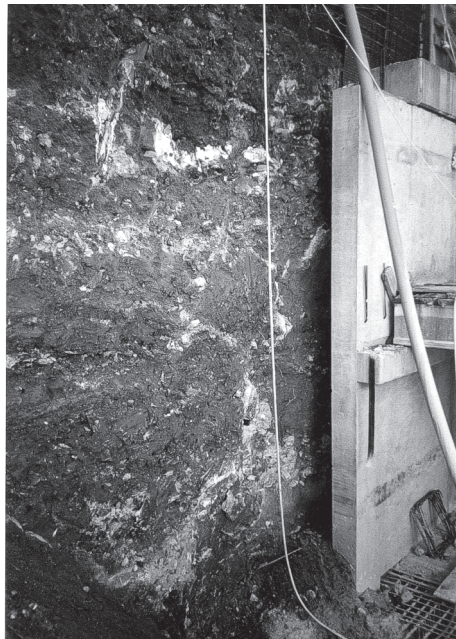
Figura 10. Vaciado para Parking en Sevilla. Detalle de la independencia del muro de cerramiento respecto al corte ejecutado (cortesía de CIMTRA).
