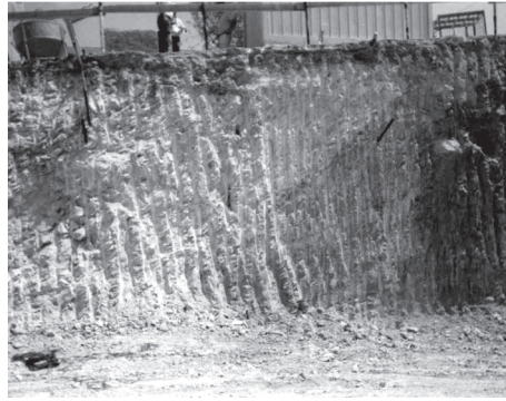
Figura 11. Vaciado para sótano en arenas (cortesía de CIMTRA).
