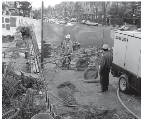
Figura 7. Abanicos de taladros ejecutados desde el exterior del edificio, dispuesto con taladros de diversas inclinaciones (cortesía de CDE Arquitectura).
