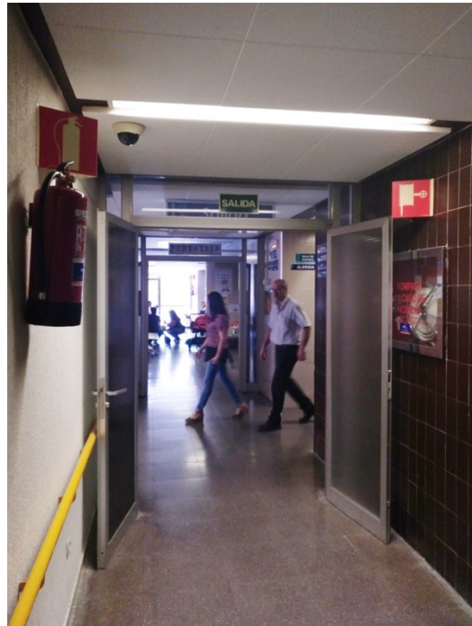
Figura 6. Intersecciones y circulaciones cruzadas en el pasillo que vertebra las comunicaciones noreste-sureste del Hospital (Fuente: G. García-Rosales).
