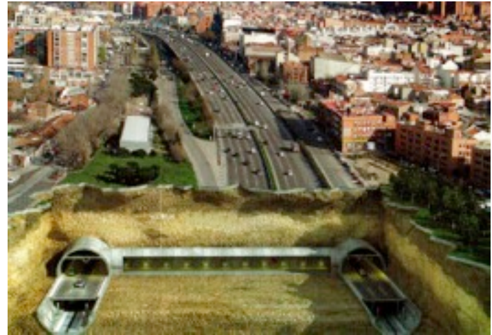
Fig. 3 – Tubos de circulación subterránea de la Calle 30. 2005-2007 (Aguiló Alonso 2013)
