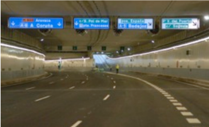
Fig. 4 – Túnel de la Calle 30. Disponible en http://noticias.coches.com última consulta 23 de diciembre de 2013
