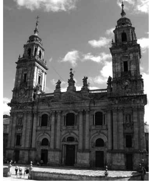
Fig. 15 - Lugo, cathedral façade (Julián Sánchez Bort, 1769).
