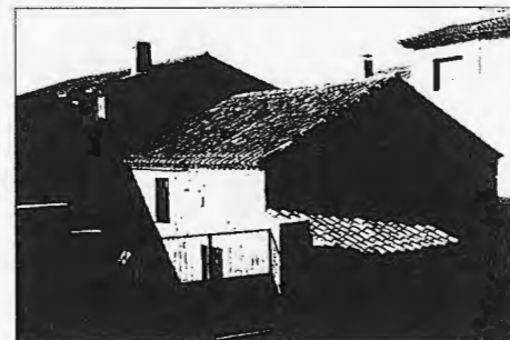
Conjunto de construcciones rurales en la calle del Arroyito. Detalle de una de las dependencias auxiliares
