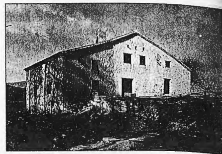
Molino del Romeralejo. Zona de desagüe
