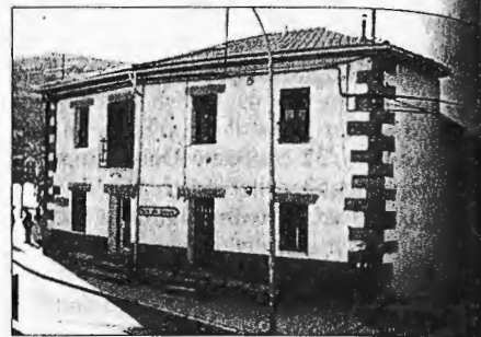
Vivienda en la calle Pablo Gasco, 23
