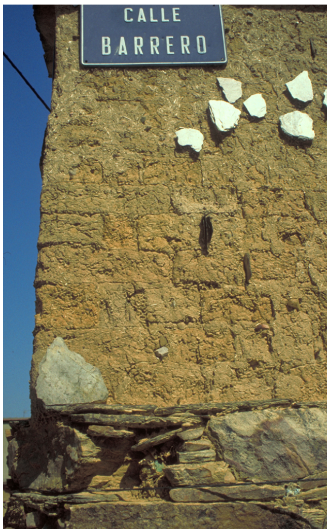
Construcción popular en Domez de Alba. Destaca el uso combinado de la piedra “ferreña” (zócalo), adobe (alzado) y pizarra (revestimiento casi perdido).
