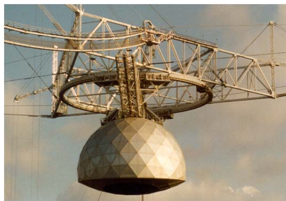
Figura 4.22.- Detalle del elipsoide que actúa como subreflector.
