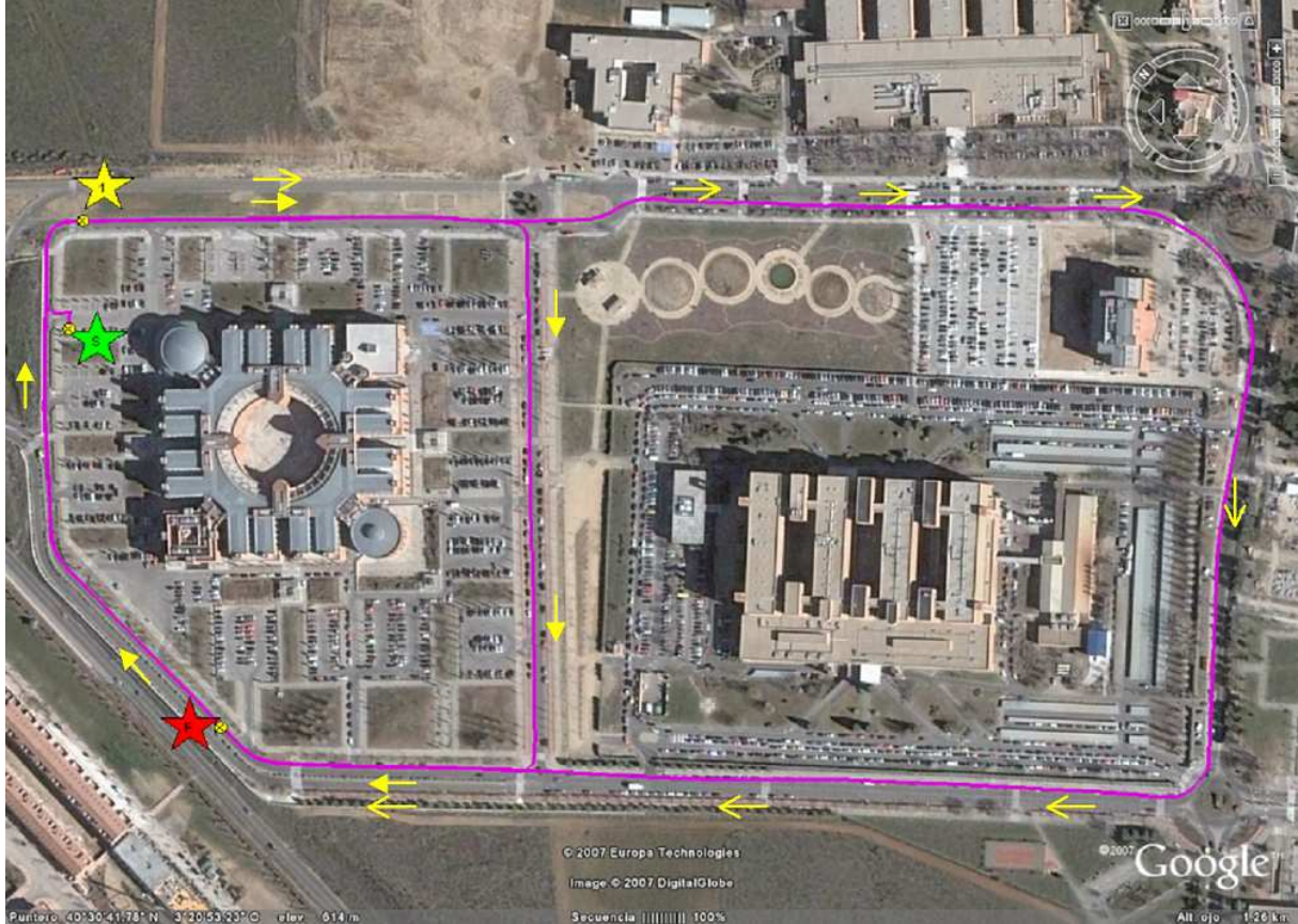
Figura 6.16: Vista aérea del camino A recorrido por el vehículo (referencia) dibujado en color magenta. El punto de partida se indica con el flag S . El punto de cierre del primer lazo se indica con el flag I . El punto de cierre del segundo lazo, y final del recorrido, se indica con el flag E
