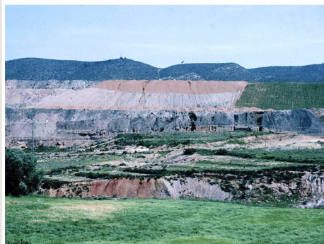
Imagen 1.2. Vista de las diferentes fases comprometidas en la restauración de las áreas alteradas por la minería a cielo abierto del carbón: conformación de la topografía, extensión de tierra vegetal y revegetación.
