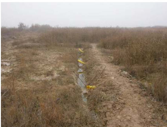
Foto 9. Construcción de los humedales experimentales.
