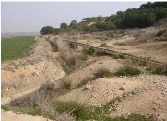
Foto 2. Infraestructuras de la transformación al riego, red de distribución (acequias) y red de desagüe (azarbes).
