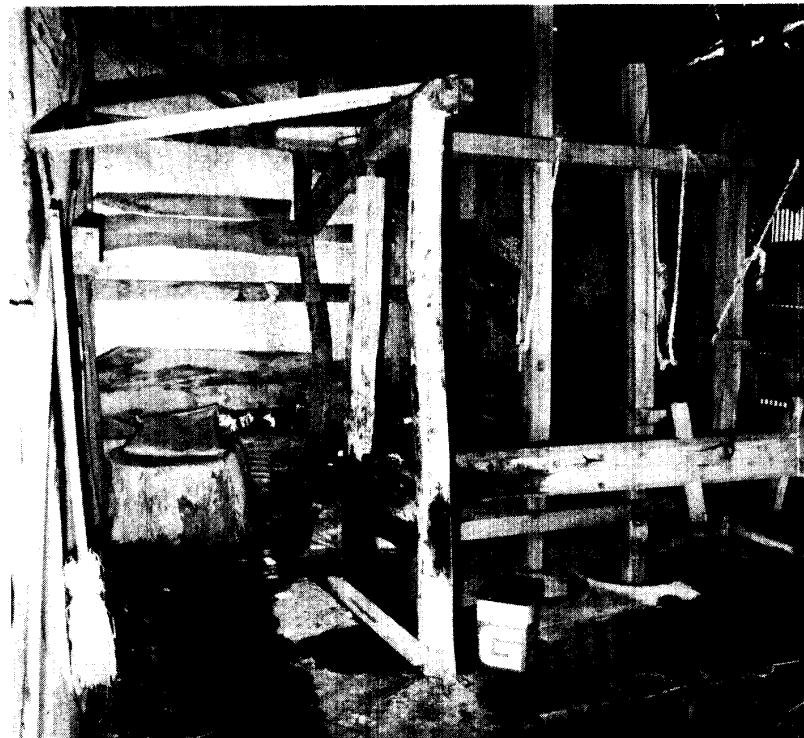
写真 12. 津山市吉見の水車小屋内部 入口は写真手前，臼は心棒の向う側。左側より奥へ入って米の出し入れをする，本来なら心棒の手前に臼をセットするが心棒の回転方向が地勢的制約により決められた為この配置となった。
