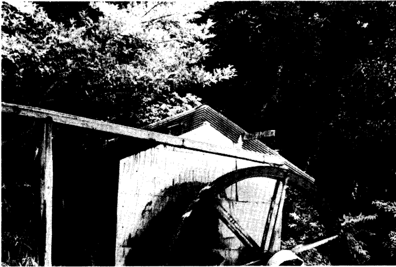
写真 1. 津山市妙原の上掛け水車 桶のため、屋根は水輪を覆 っていない。水にあたる側 面はトタン張りである。
