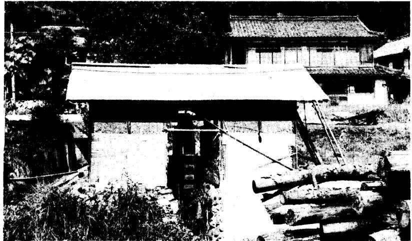
写真 11. 加茂川町加茂市場の鉄製水車 小屋の左が一臼，右が二臼の水車小屋である。今日は屋根の修理をしている。
