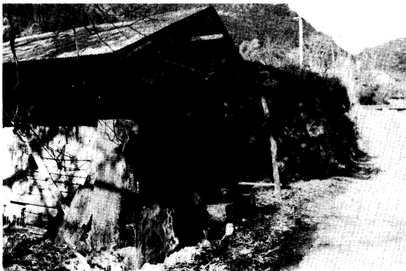
写真 3. 加茂町公郷上大 水の勢いを回転に役立てて いる上掛け改良型。冬は水 が付着して廻りにくくなる という。
