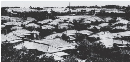
【図33 明治専門学校校舎宿舍全景】
