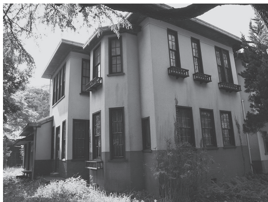
【図24 (現状) 安川邸第二次居宅】
