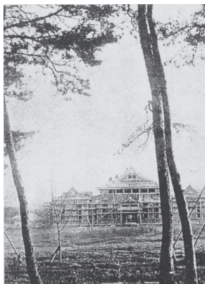
【図31 建設中の本館】
