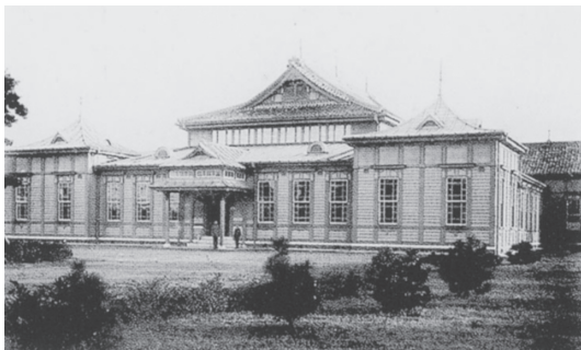
【図32 辰野設計の完成した本館】
