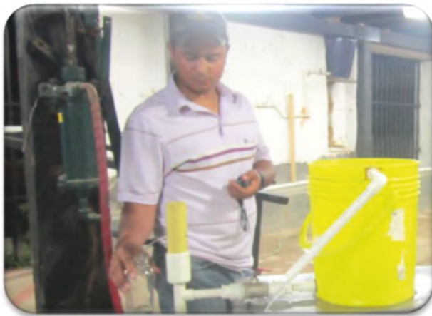
Figura 3. Unidad de control y medición de caudal
