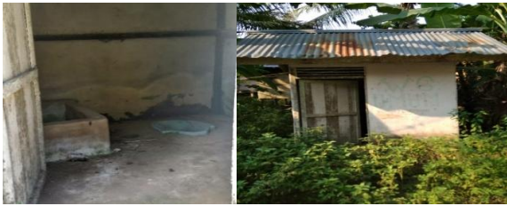
Gambar 4. Jamban Desa Sebelum Renovasi
