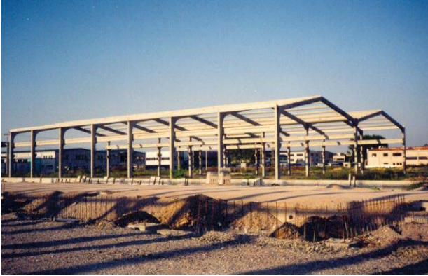
Örnek yapının 1999 Marmara depremi öncesi durumu
