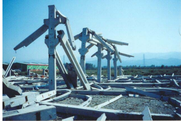
Örnek yapının 1999 Marmara depremi sonrası durumu
