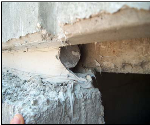
Şekil 7. Balkon prekastı ile duvar arası boşluğa yapılan uygulama.
