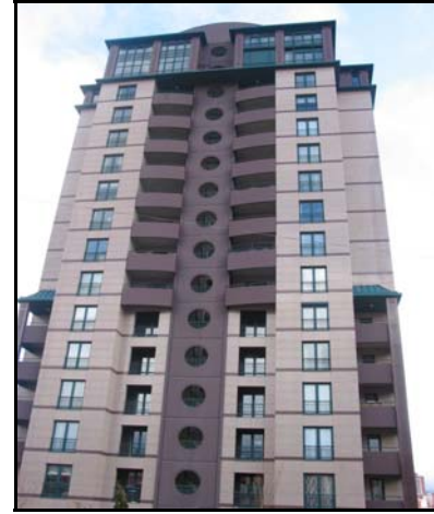
Şekil 16. Mesa uygulamaları - Şafak sitesi örneği.
