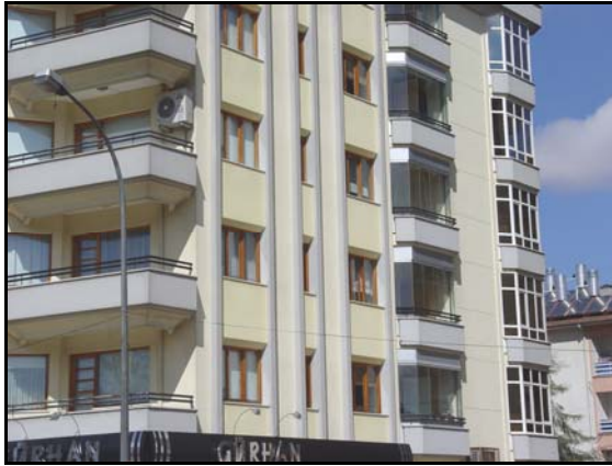
Resim 17. Örnek balkon kapatma sistemleri (Sayın arşivinden).
