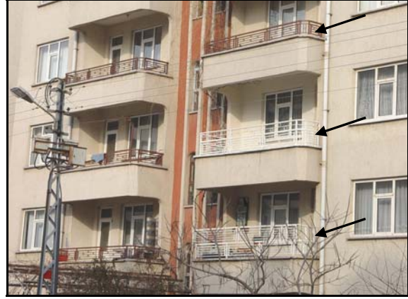
Resim 8. Balkon korkuluklarına ilave yapılarak yükseltilmesi (Korur arşivinden).
