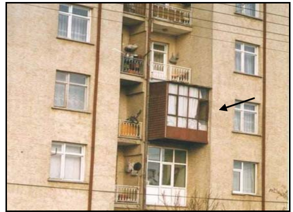
Resim 3. Balkonun dışarı doğru büyütülerek kapatılması (Korkmaz arşivinden).
