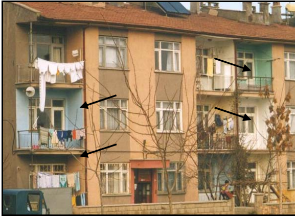
Resim 6. Balkonlarda kullanıcıların dış cephe rengini değiştirmesi (Korkmaz arşivinden).
