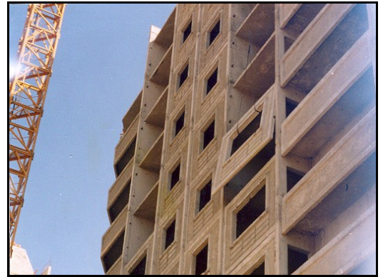
Resim 5. Prekast cephe panelinin vinç vasıtasıyla yerine taşınması.
