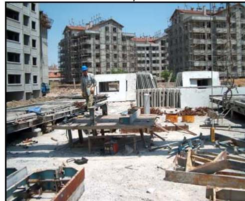
Resim 2. Şantiyede kurulan prekast eleman döküm atölyesi.
