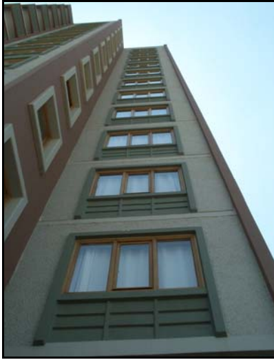
Resim 3. Prekast cephe panellerinin cepheye kazandırdığı hareketlilik.
