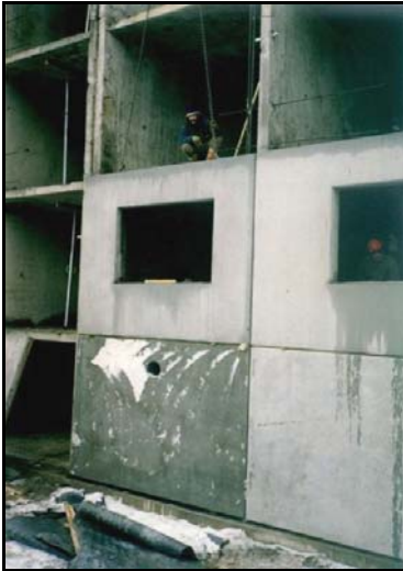
Resim 7. Sandviç cephe panelleri uygulaması. Photo 7. The application of sandwich facade panels.
