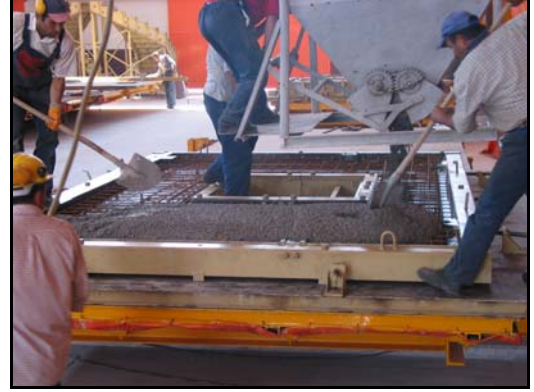
Resim 4. Vibrasyonlu masada prekast cephe paneli üretimi.
