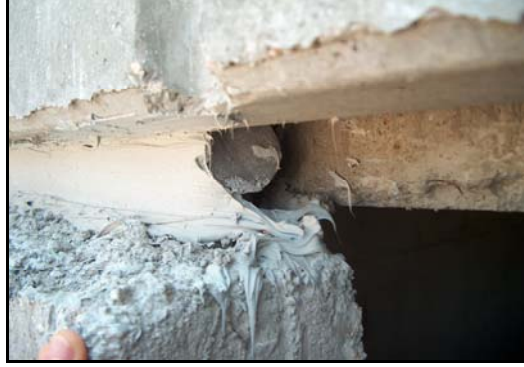
Resim 12. Prekast cephe elemanı ile duvar arası boşluğun dışarıdan izolasyonu.
