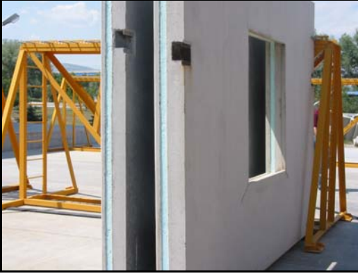
Resim 6. Arasında ısı yalıtımı katmanı bulunan sandviç paneller.
