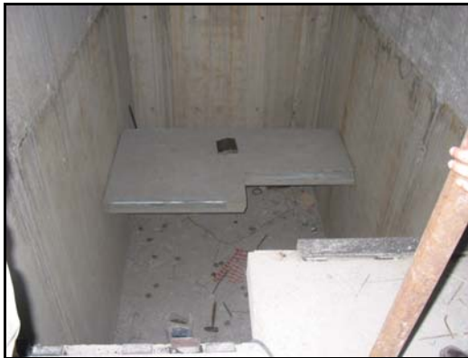
Resim 10. Prefabrike olarak üretilen ara sahanlığın yerinde montajı.
