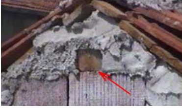
Şekil 2. Sıvasız kalkan duvarın görünümü. Figure 2. The view of without plaster gable wall.
