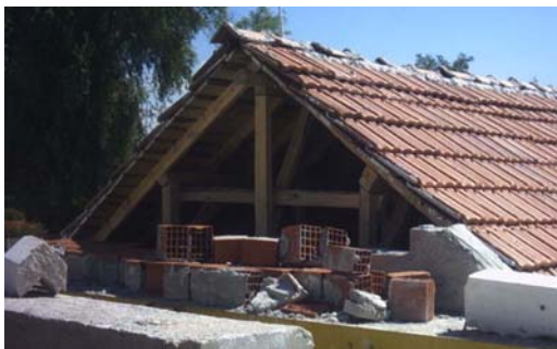
Şekil 18. Altıncı yükleme sonunda yıkılan sıvalı kalkan duvar.
