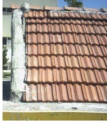
Şekil 14. Sıvalı kalkan duvarın görünümü.
