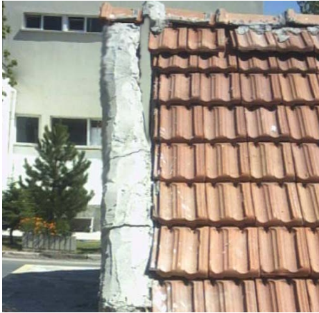
Şekil 17. Dördüncü yükleme sonunda sıvalı kalkan duvarın görünümü.
