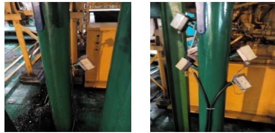
Gambar 6. Pipa JW dan Pipa ICW setelah instalasi
