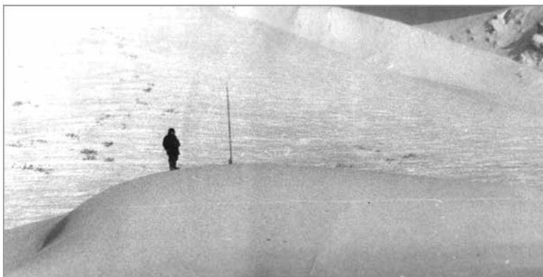
**Рис. 3.** Массив искусственного фирна высотой 6,7 м, намороженный за 19 часов непрерывной работы дождевателя ДДН-70 при температуре воздуха  $-17$  °С
