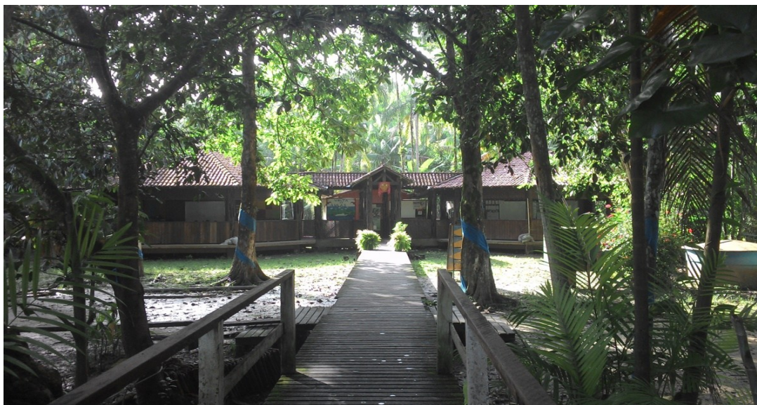
Figura 8 – Escola municipal da ilha do Combu, Belém-Pa
