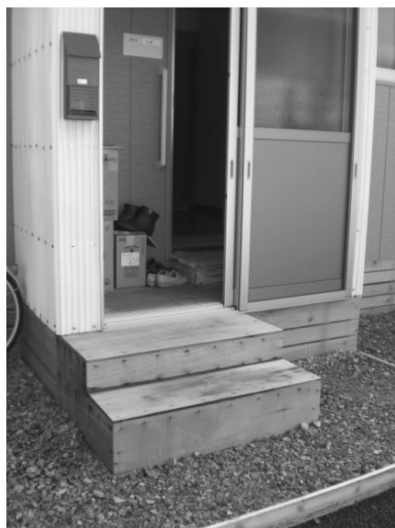
写真6 仮設住宅 玄関
