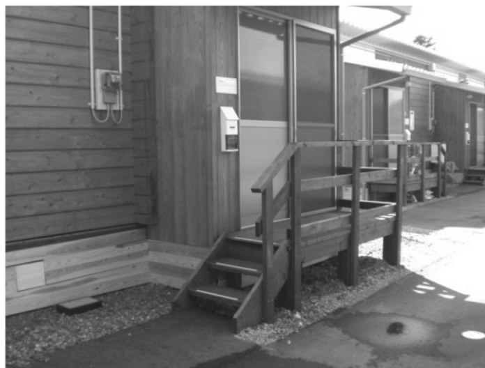
写真7 仮設住宅 玄関
