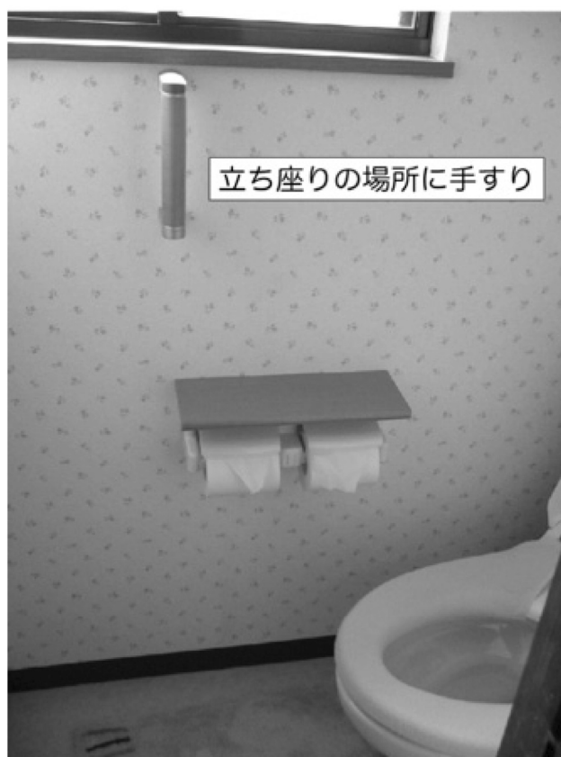
図4 手すりの設置
