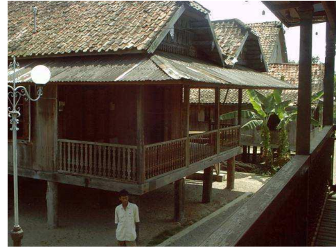
Gambar 2. Rumah Gudang Sumber: Murod, dkk, 2002
