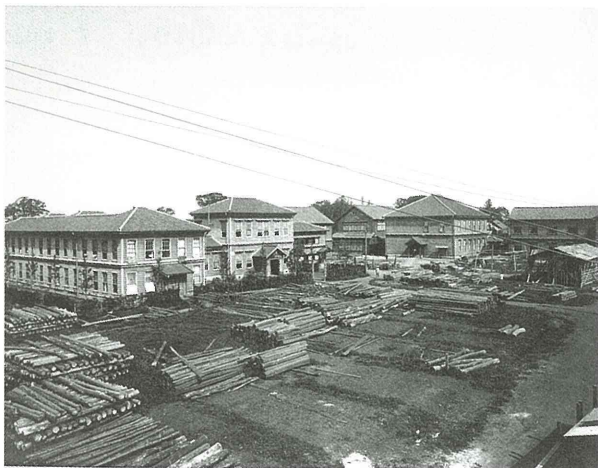
写真3 新大久保敷地に積み上げられた木材と建築中の校舎
