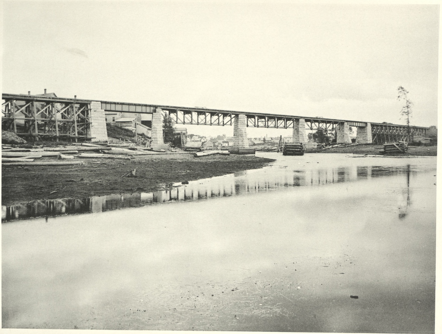
B. & A. R. R. BRIDGE ON MEDUXNEKEAG RIVER, HOULTON.
