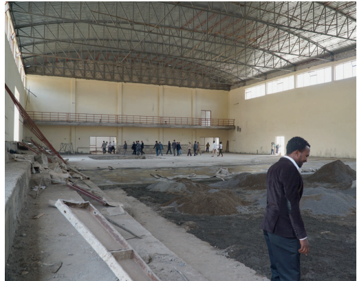
Die im Bau befindliche Sporthalle der Arsi University
