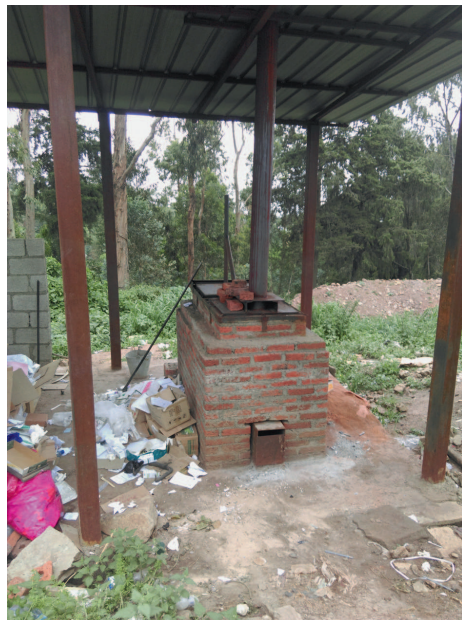
Der neu errichtete Verbrennungsofen im Juni 2016
