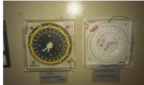
Mit der neuen Zeitschaltuhr konnte die Kläranlage wieder in Betrieb genommen werden.
