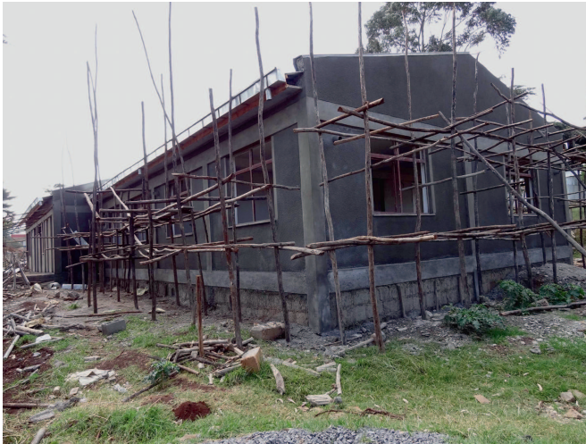
Der traditionell eingerüstete Rohbau des Hirsch Instituts im Jahr 2011
