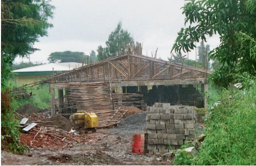
Rohbau des Instituts (2011)
