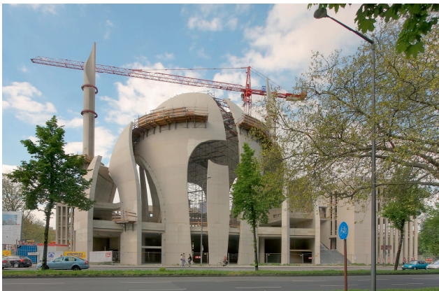
Abb. 8: Rohbau der DITIB-Zentralmoschee, Köln Ehrenfeld (Foto: Raimond Spekking)
