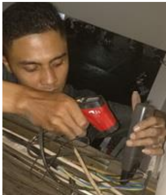
Gambar 3.3 penekukan kabel sebesar 135°
