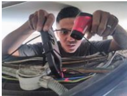
Gambar 4.1 penekukan kabel sebesar 30°.
