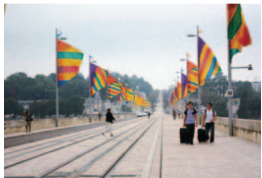
図5-16 ウィルソン橋の現状
