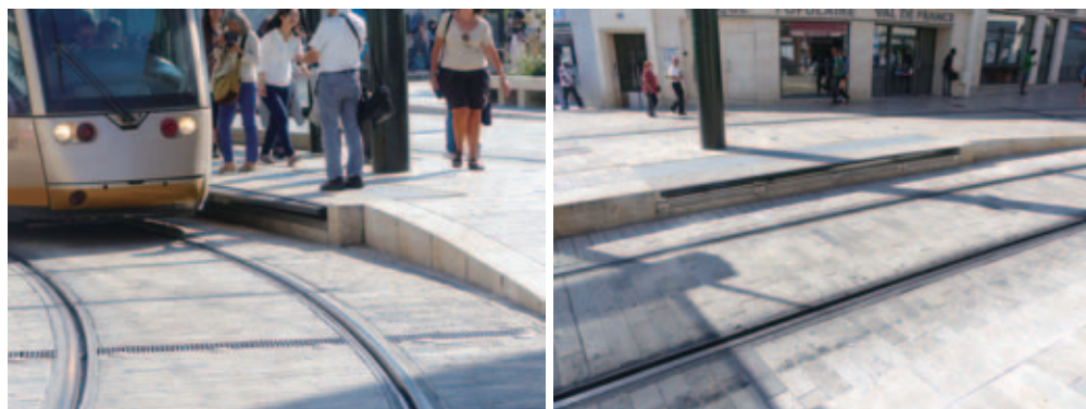
図4-9 プラットホームから補助板が出る仕組み
