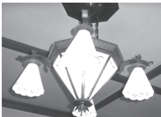
写真-19 食堂照明器具
