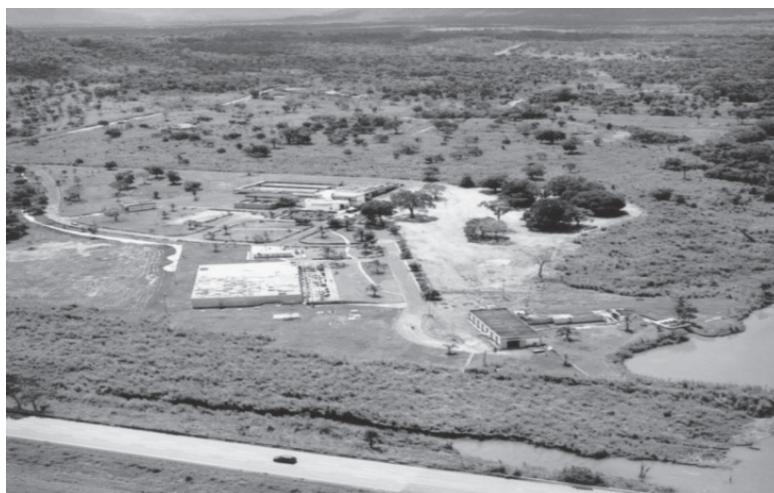
Figura 3. Vista aérea da Estação de Tratamento de Água - ETA 06 em Palmas, TO (adaptado de Silva et al. , 2006).
